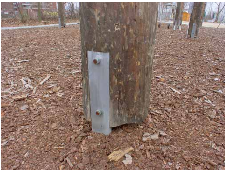
Abbildung 4: Fundament eines Tragwerkssystems
